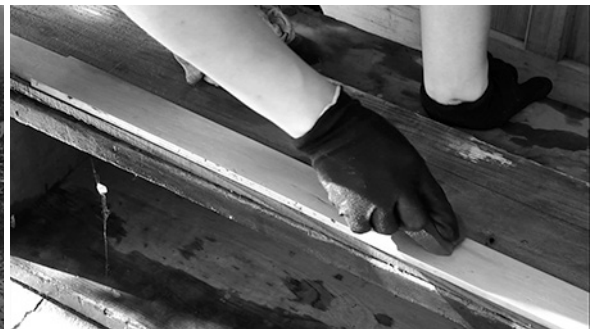
写真234 研磨仕上げ
