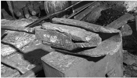
写真148 「3次組み合せた鉄塊」の完成
