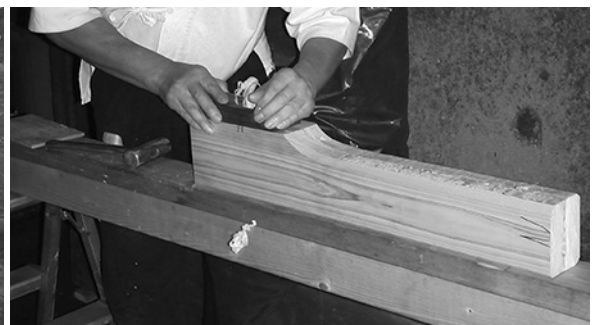
写真19 接着面を整える
